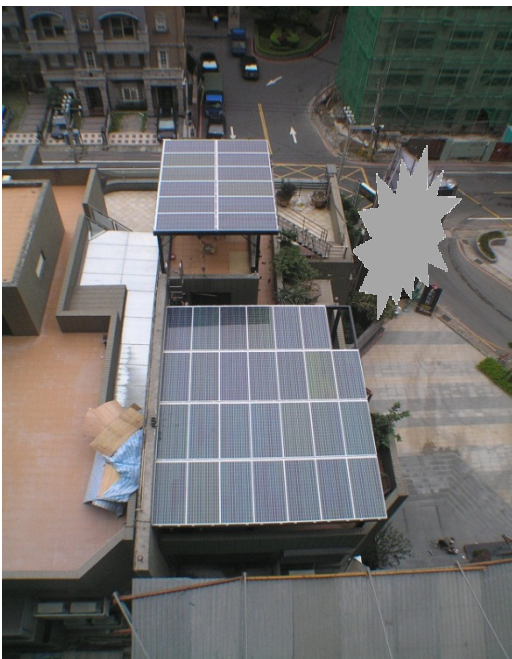
工程實績二：屋頂採光罩,降溫又賣電
